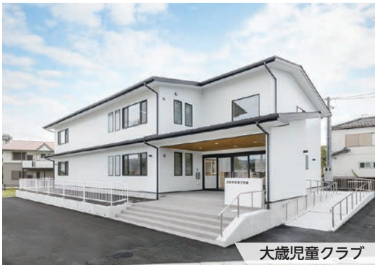
農林業拠点施設
