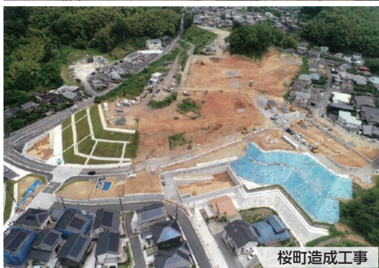
体育館新築工事
