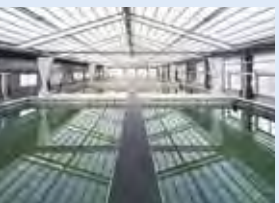
山口県内海栽培漁業センター種苗生産棟新築工事
