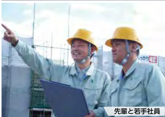
徳山駅ビル工事
